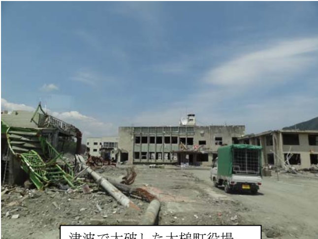
津波で大破した大槌町役場
